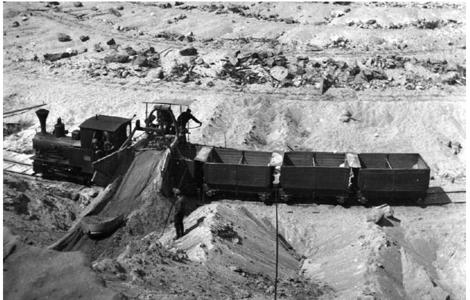
HÖYRYHIEKKAA. Porvoon maalaiskunnan Kråköns hiekkakuopilta lastit kuljetettiin höryveturin vetämillä vaunuilla lastauspaikalle. Hiekka vedettiin vaunuun kahmarilla. Kuva: Gunnar Kronvall.
