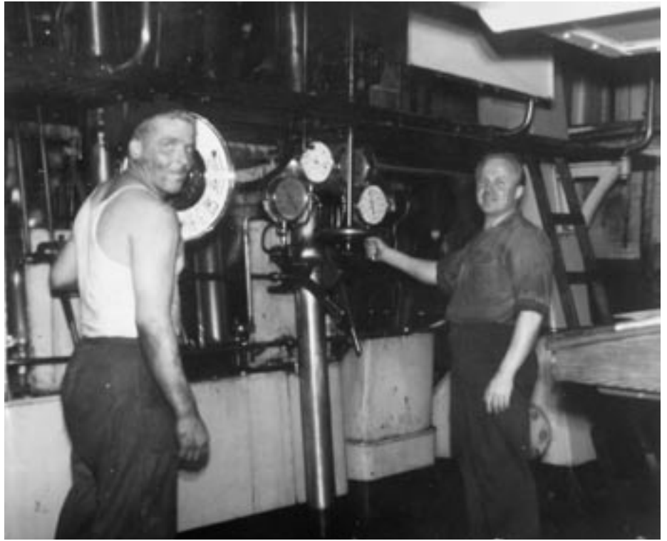
Oihonnan konehuoneen höyryputkiviidakkoa.
